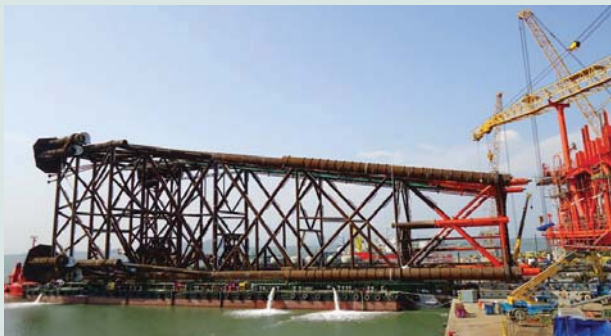
Chân đế giàn DH2 được vận chuyển và hạ thủy bằng sà lan chuyên dụng. Ảnh: VSP
